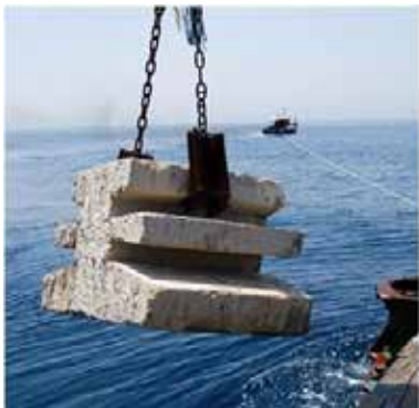
Figure 14: Des modules de RA adaptés par N. Haddad pour jouer le rôle de protection et de production, immergés en 2011-2012.
