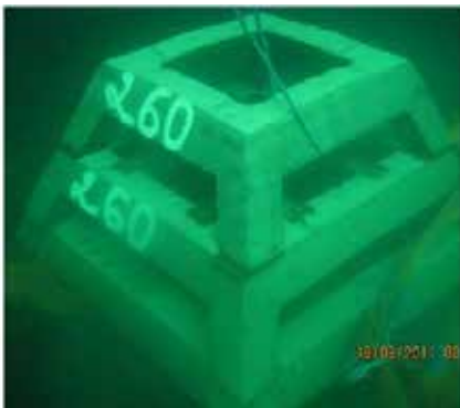
Figure 14: Des modules de RA adaptés par N. Haddad pour jouer le rôle de protection et de production, immergés en 2011-2012.
